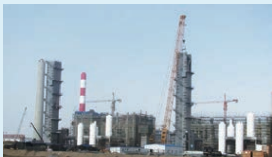
空分施工现场
