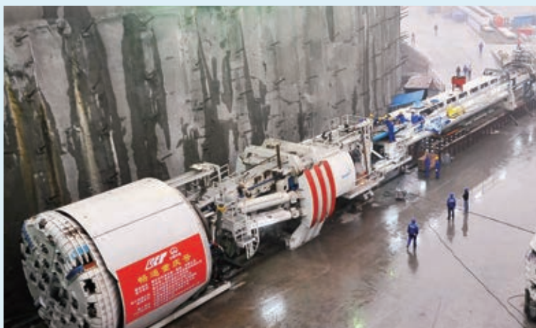
重庆地铁六号线一期首次成功运用TBM掘进技术
